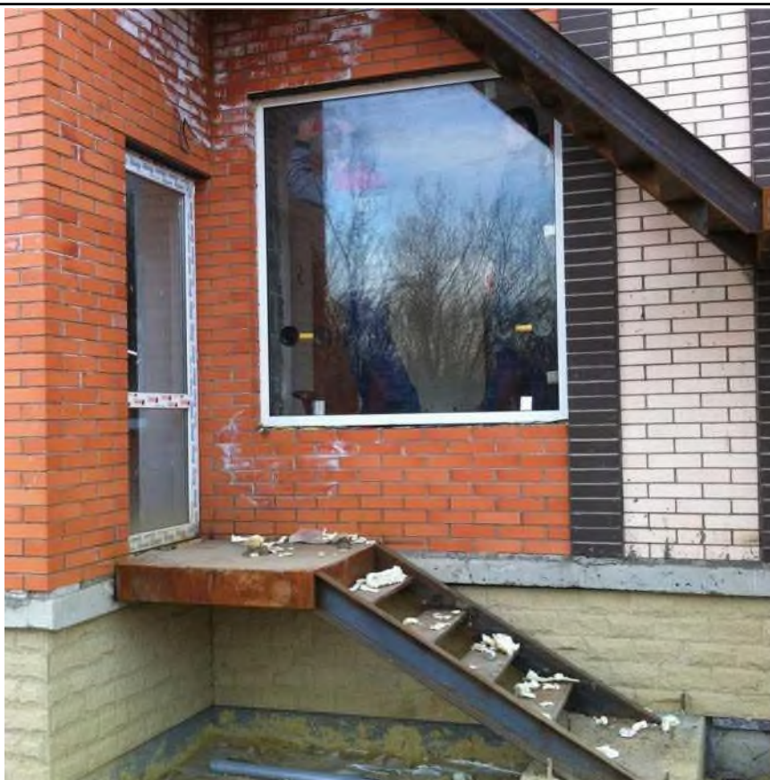
Рис. 6. Монтаж противопожарного окна
