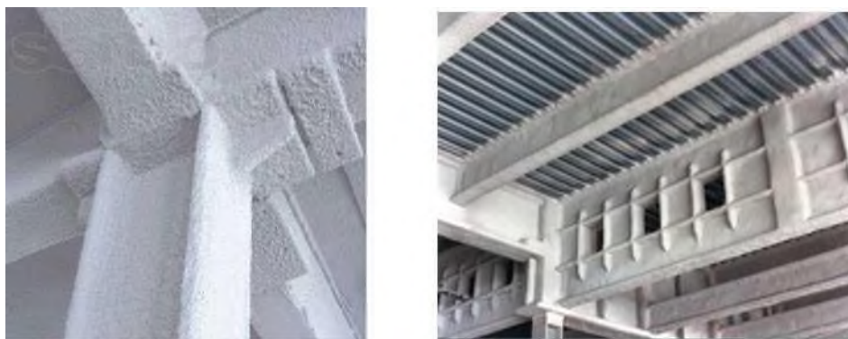
Рис. 1. Огнезащита стальных конструкций с применением вспучивающихся красок.
