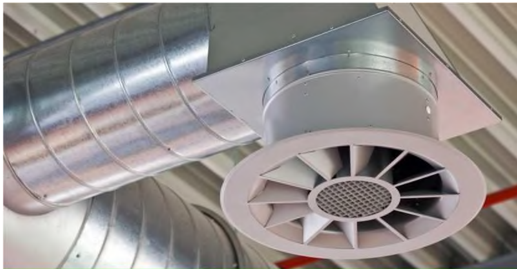
Рисунок 3. Приточная противодымная вентиляция
