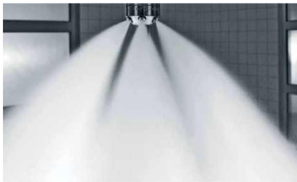
Рис. 2. Оросители для создания тонкораспыленных водных струй.
