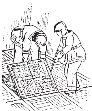
Рис. 4.9. Вскрытие щитового паркета
