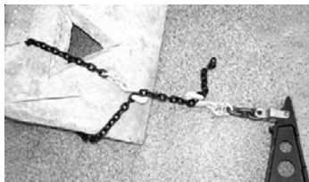
Рис. 4.43. Стягивание элементов конструкций
