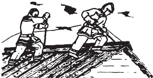
Рис. 4.8. Вскрытие толевой (а) и тесовой (б) кровель
