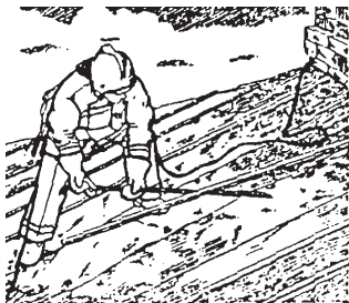
Рис. 4.8. Вскрытие толевой (а) и тесовой (б) кровель
